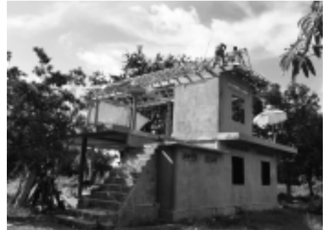
건축 중인 캄보디아 유기농업 교육센터
